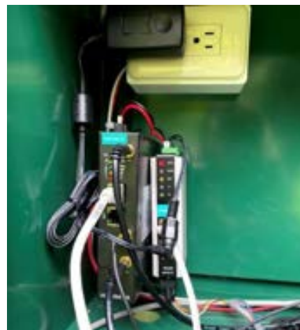
PV-Gateway (含Modbus Gateway) 安裝及盤內接線
